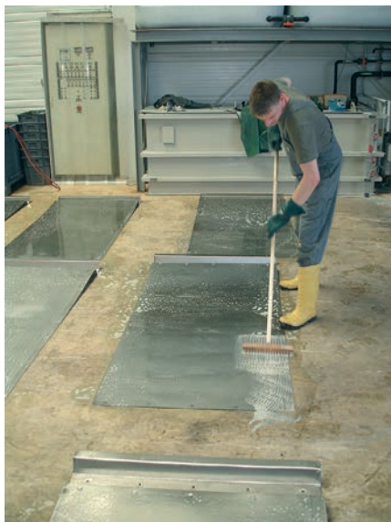
Auftragen und Einarbeiten von FR-D 50.
