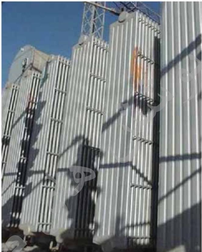
شکل هفت: نمونه رفع نشتی پس از سخت شدن پوشش
