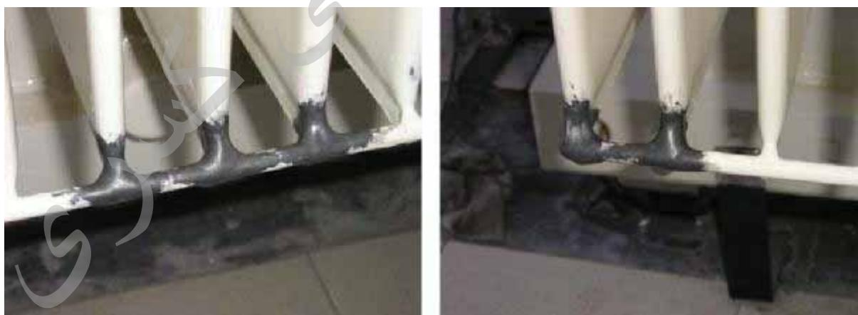
شکل شش: نمونه رفع نشتی پس از سخت شدن پوشش
