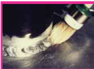
درزبندی کامل ترک‌ها، خلل و فرج بارزین نشستی گیری
