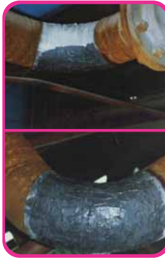
آب بندی لوله‌های آب گرم در تاسیسات گرم کننده
