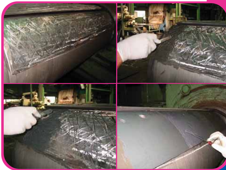
تعمیر و بازسازی سطوح فرسایش یافته در قطعات فولادی
