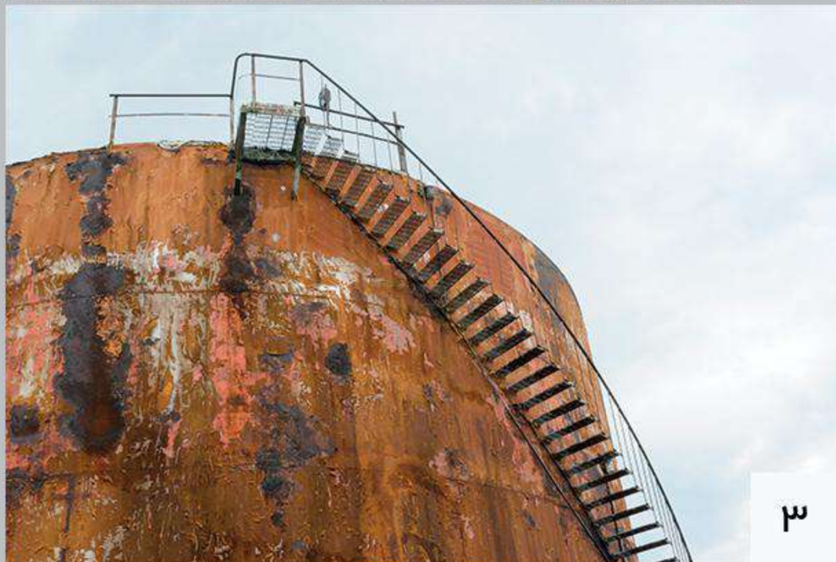
۱- خوردگی شیاری بتن بر اثر ریزش اسید نیتریک ۲- خوردگی فولاد بر اثر نشی آب داغ ۳- خوردگی مخزن فولادی نگهداری اسید سولفوریک ۴- خوردگی بتن تا آرماتور بر اثر تنش‌های حرارتی
