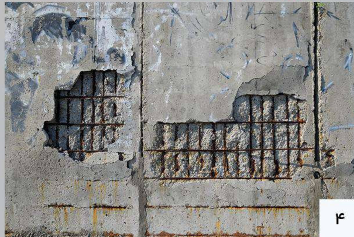
۱- خوردگی شیاری بتن بر اثر ریزش اسید نیتریک ۲- خوردگی فولاد بر اثر نشی آب داغ ۳- خوردگی مخزن فولادی نگهداری اسید سولفوریک ۴- خوردگی بتن تا آرماتور بر اثر تنش‌های حرارتی
